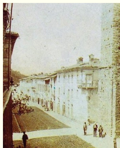
FOTO A: Negozi da Torre verso valle
