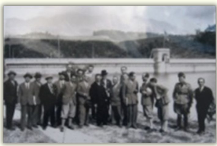
Inaugurazione della diga sullo Scandarello. Ancora non era stata realizzata la carruggiabile Salaria, troncone del progetto della strada provinciale della Meta.
